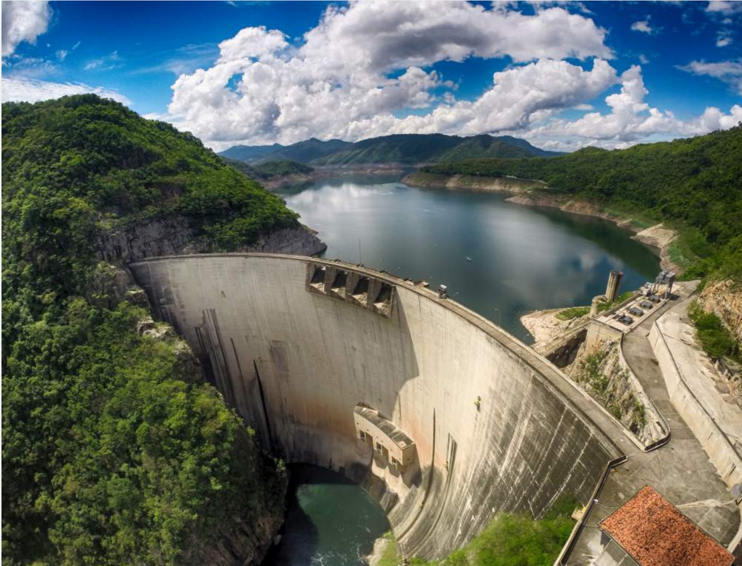
Represa el Cajón, Honduras
