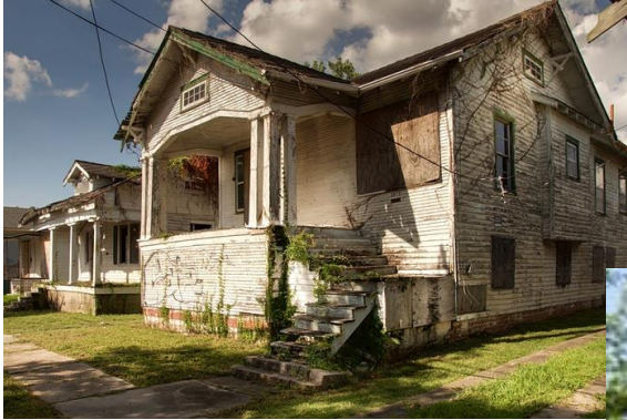
Casa de Nueva Orleans después del Katrina
