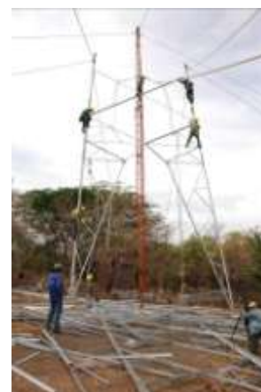
Avance de obra SIEPAC
