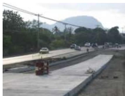
Construcción carretera transistmica en Panamá (abril de 2008)
