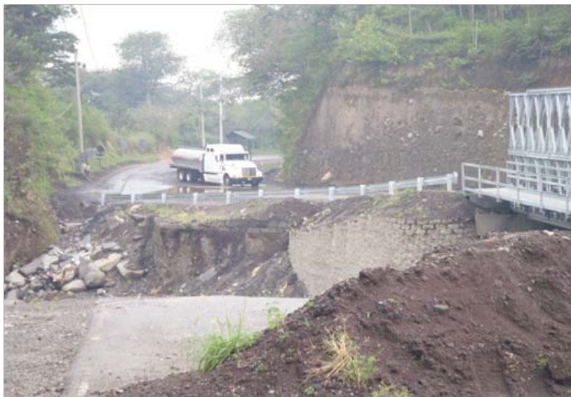
Figura 3-10: Puente mecano alternativo carretera entre Puerto Quetzal y C. Guatemala
