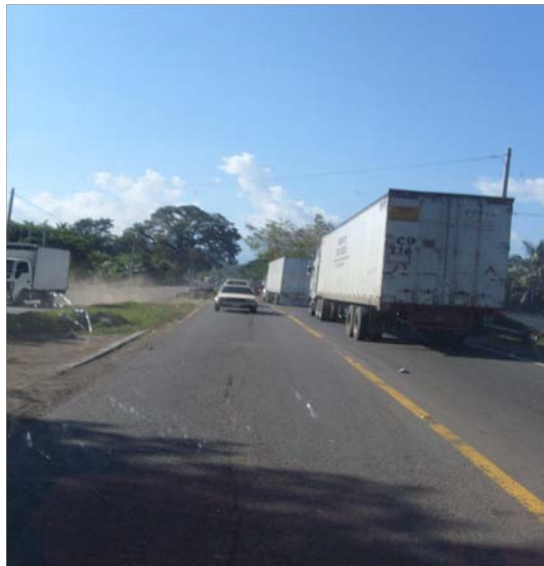
Figura 3-8:Carretera principal entre La Ceiba y Puerto Cortés
